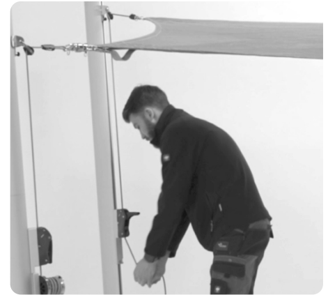
13 Abschließend wird überprüft, ob das Segel korrekt gespannt ist.
