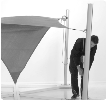
11 Der Schnappschäkel wird mit dem Segeleck verbunden, um das Segel zu spannen.
